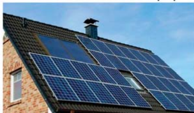
INSTALACIÓN DE PLACAS PARA AUTOCONSUMO
